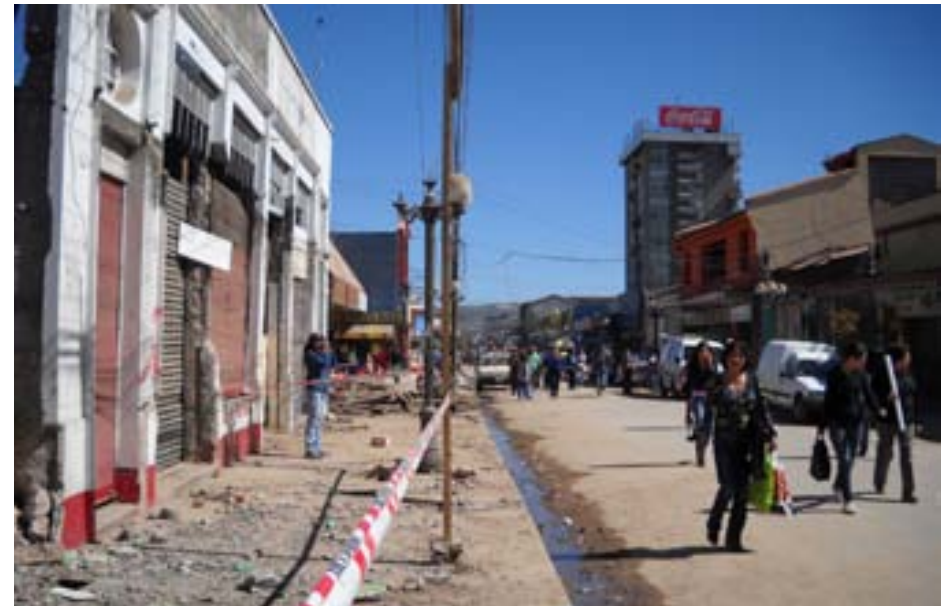
Veredas cerradas por riesgo de derrumbe de las edificaciones, iluminación peatonal rota, rotura de matriz de agua. Estas situaciones generan una alta percepción de desorden social. Calle1 Sur, sector comercial, Talca.
