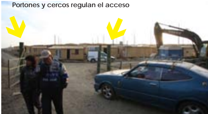
Portones y cercos regulan el acceso
