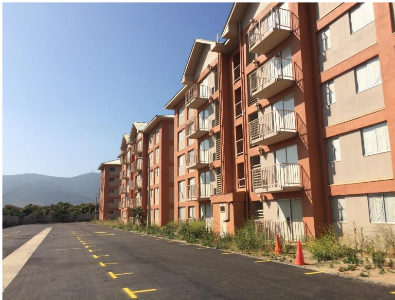
Figura 6 Conjunto sin residentes comuna de La Calera, región de Valparaíso.
