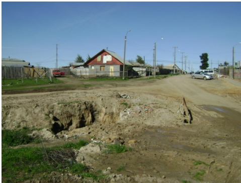
Antes del Entubamiento Obra de Confianza. Villa Esperanza I – II.
