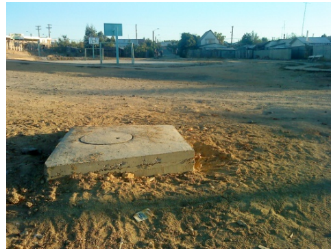
Después del Entubamiento Obra de Confianza. Villa Esperanza I – II.
