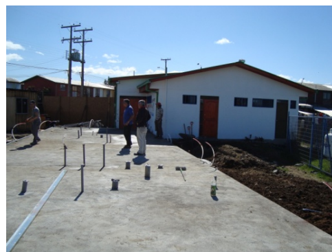
En proceso de ejecución Ampliación Sala Cuna. Villa Esperanza III.
