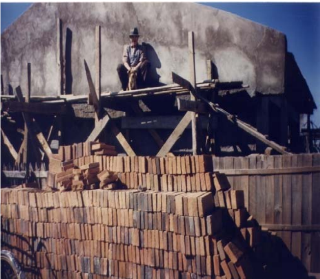
Construcción Vivienda, Villa Retulemu.
