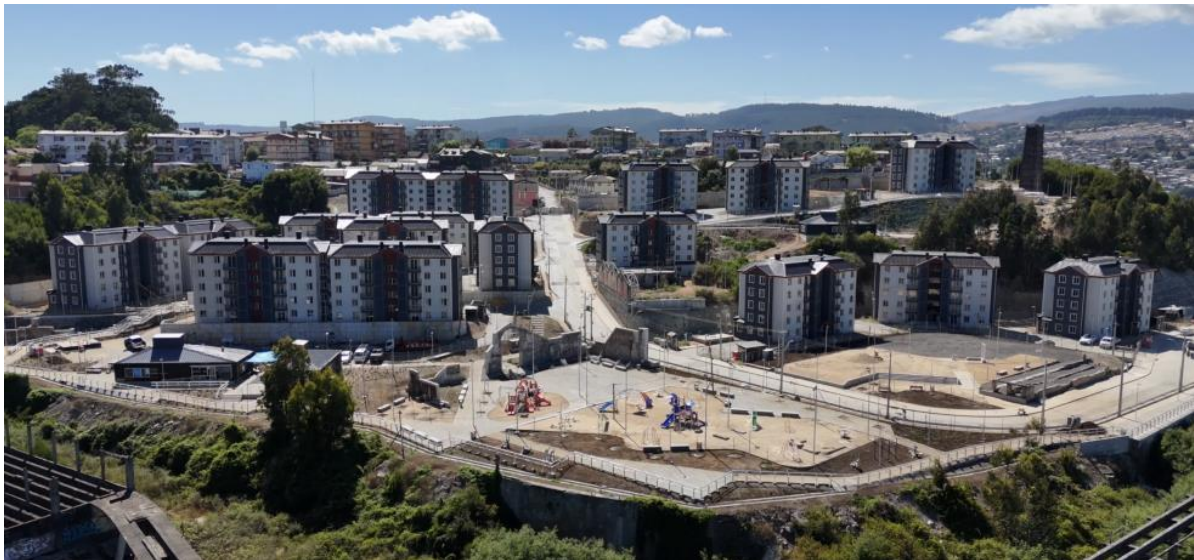
Figura 7. Proyecto habitacional Lota Green. Fuente: Subdere.
