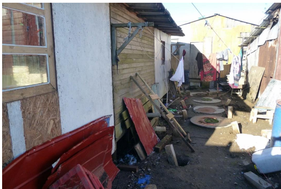
Figura 9. Patio de vivienda en el campamento, su ocupación
